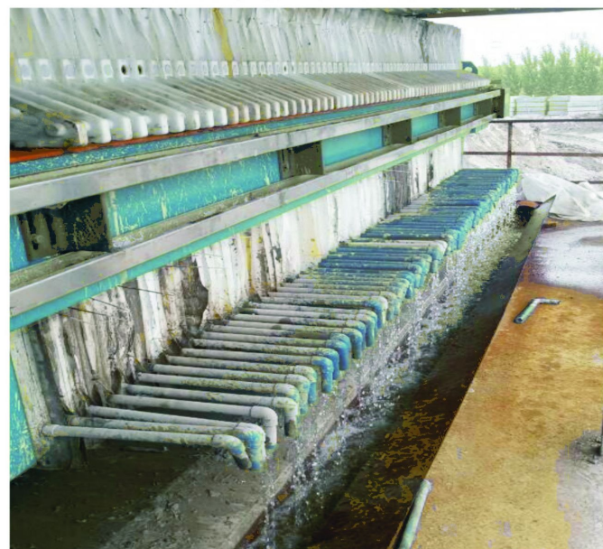
城市生活垃圾污泥处理
